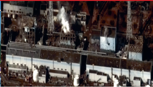
Kernkraftwerk Fukushima Daiichi nach der Tsunami-Katastrophe im März 2011. Foto: DigitalGlobe
